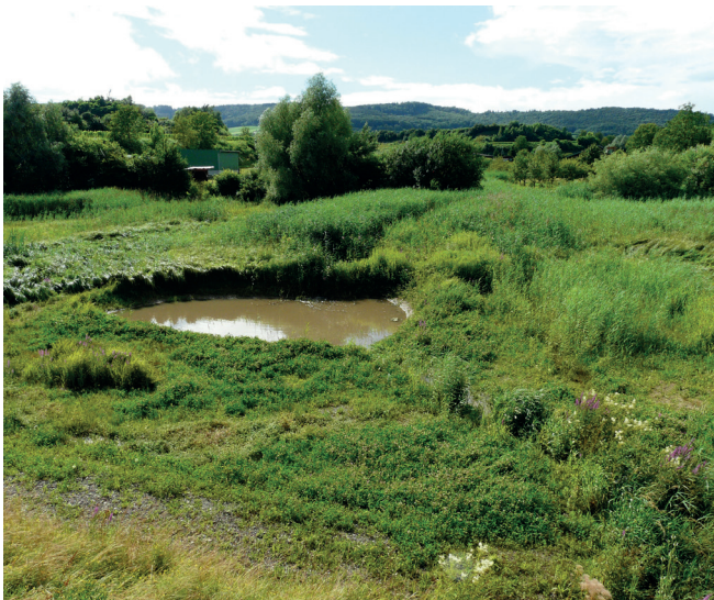
Bild 6: Das neu angelegte Feuchtlächensystem im Hochwasserrückhaltebecken Breitenweg, Gemeinde Eichstetten am Kaiserstuhl; © Jens Lange, 2018
