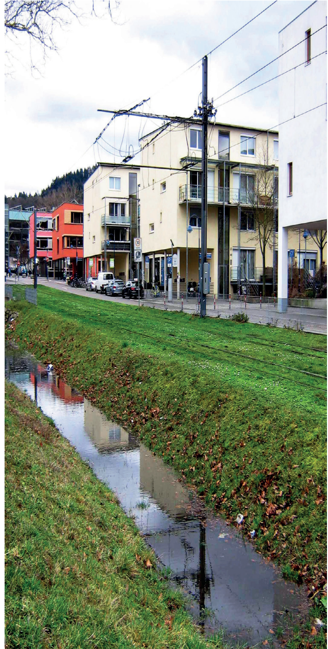
Bild 8: Untersuchte Versickerungsanlage mit Blick auf das Einzugsgebiet, © Stadt Freiburg, Nicole Jackisch, 2018
