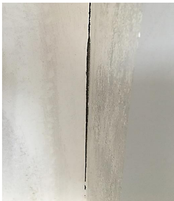
Bild 3: Unregelmäßig ausgeführter Trennschnitt
