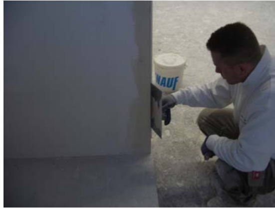
3. Spachteln der Fläche mit „Finish“- Spachtelmasse
