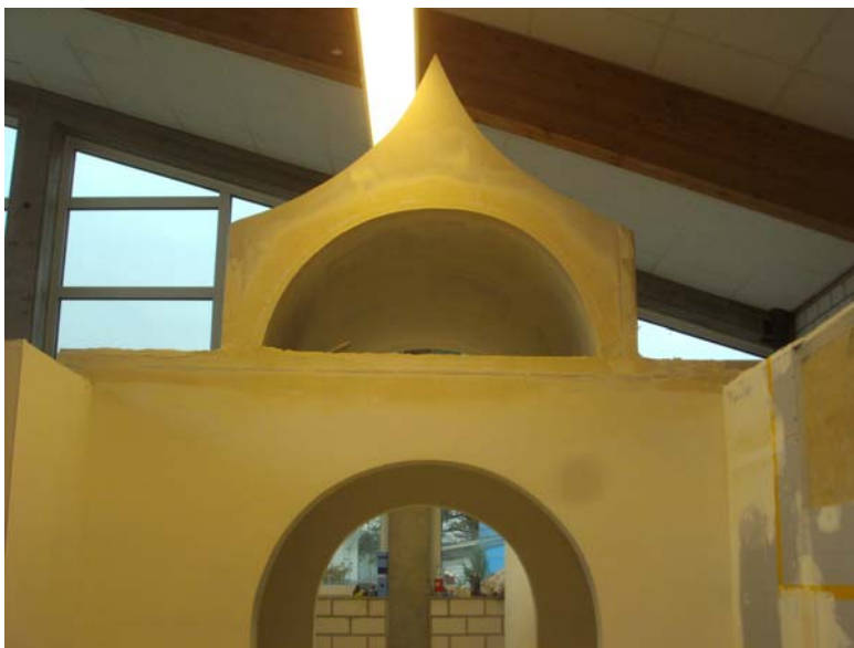
Arbeitsschritte Trockenbau 2014 - Vitali Romme / Peter Schwan
