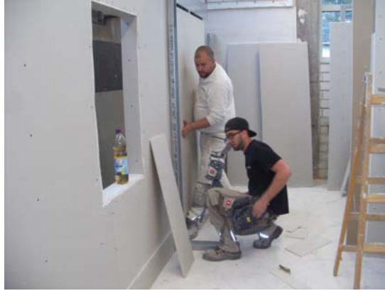
9. Beplanken der Wandkonstruktion und anbauen der Wandanschlüsse
