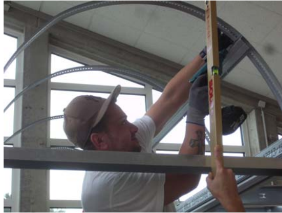
11. Befestigen der Profile für die Decke und das Tonnengewölbe
