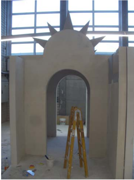
Arbeitsschritte Trockenbau 2014 - Vitali Romme / Peter Schwan
