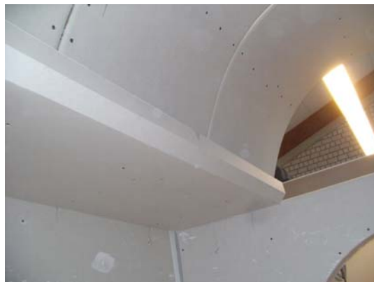
18. Einbau der Lichtvoute
