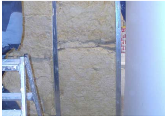
17. Montage und Beplankung der Schachtwand
