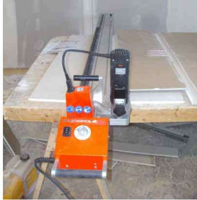
15. Fräsen der Gipskartonplatten für die Lichtvoute
