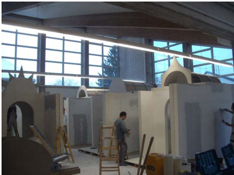
Arbeitsschritte Trockenbau 2014 - Vitali Romme / Peter Schwan
