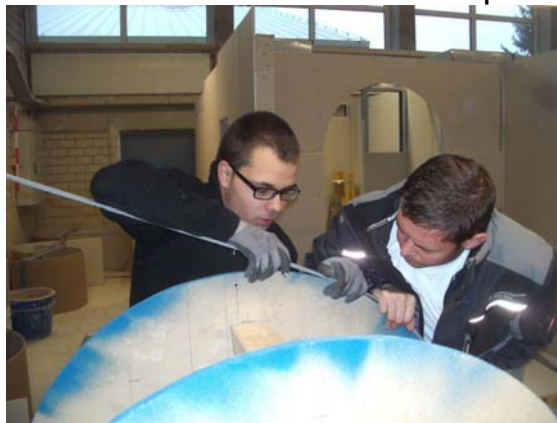
10. Biegen der Profile für das Tonnengewölbe auf der Schablone
