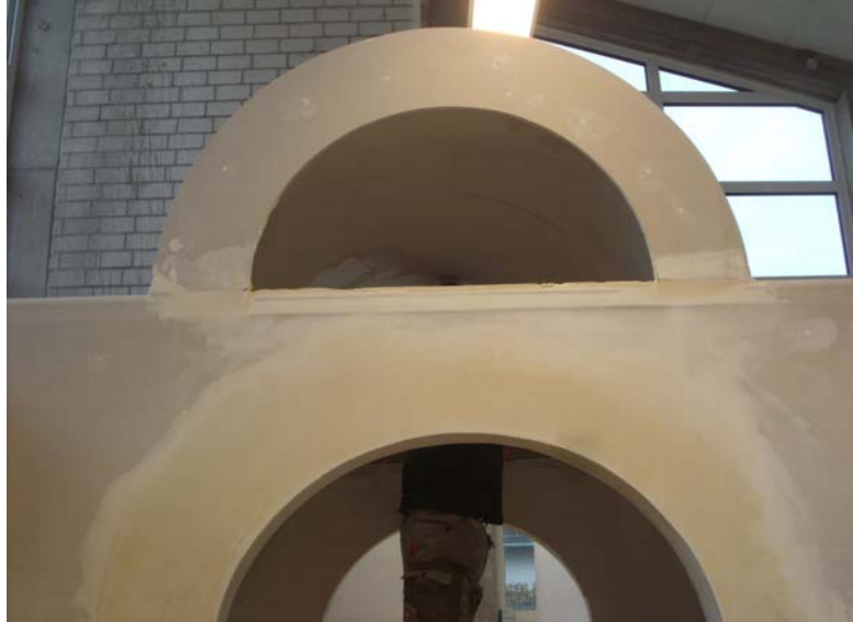
Arbeitsschritte Trockenbau 2014 - Vitali Romme / Peter Schwan
