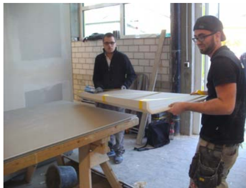
16. Kleben der Lichtvoute und fixieren mit Klebeband – Trocknungszeit 24 Stunden
